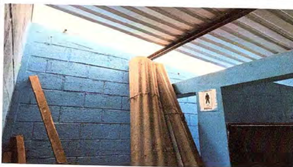
FOTO 1.2: ENTECHADO DE LAMINA DE SERVICIOS SANITARIOS
