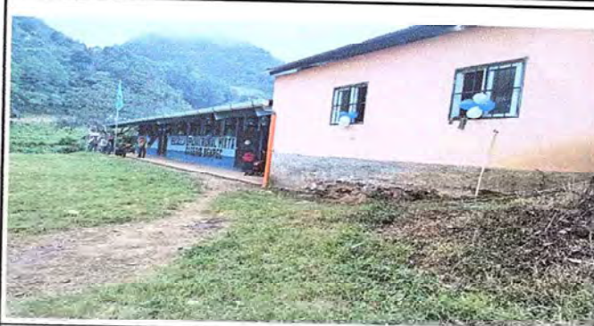
FOTO 1.2: SUSTITUCION DE VENTANAS A PVC
