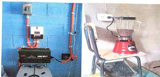
FOTO 1: SUSTITUCION DEL SISTEMA ELECTRICO
