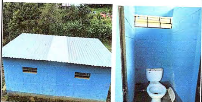
FOTO 1: SUSTITUCION DE LAMINAS DE SERVICIOS SANITARIOS
