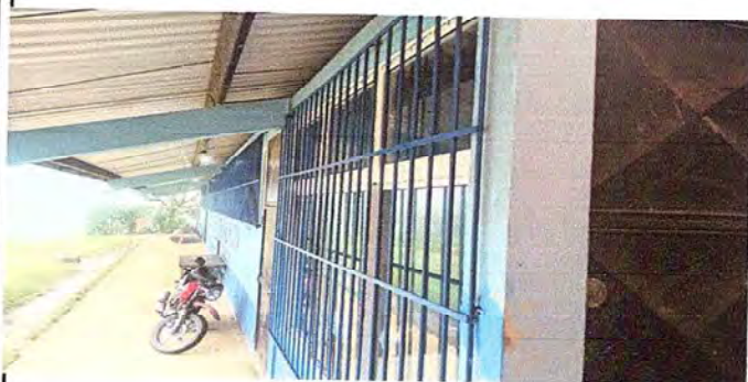
FOTO 1: SUSTITUCION DE BALCONES
