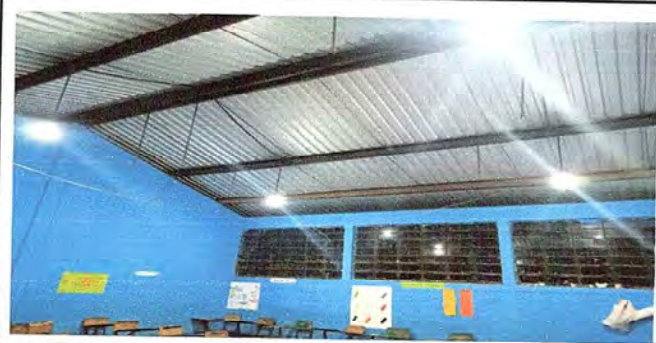
FOTO 1: SUSTITUCION DEL SISTEMA ELECTRICO
