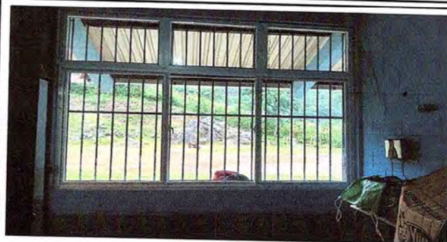
FOTO 1.2: SUSTITUCION DE VENTANAS A PCV
