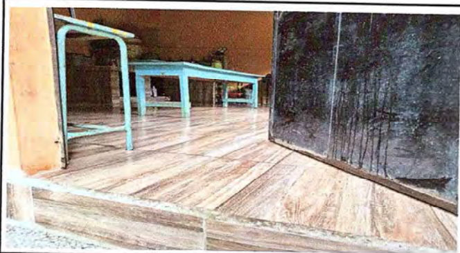
FOTO 1: SUSTITUCION DE PISO A CERAMICO
