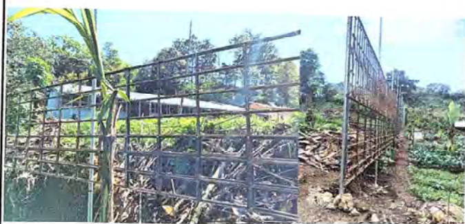
FOTO 1: MEJORAMIENTO DE CERCO PERIMETRAL, LADO PONIENTE
