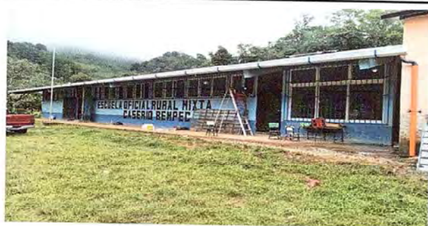
FOTO 1: SUSTICION DE CANAL BAJADA DE AGUA PLUVIAL
