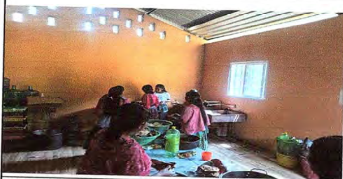
FOTO 1: SUSTITUCION DE VENTANAS DE LA COCINA
