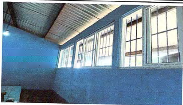
FOTO 1: SUSTITUCION DE VENTANAS A PCV
